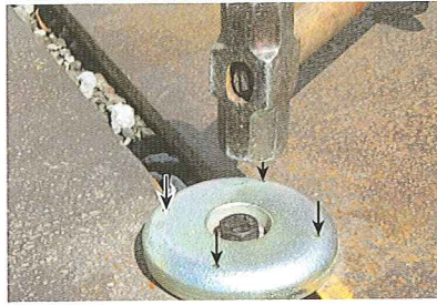
5.ハンマーでピンの穴部を強く叩きピンをより深く食い込ませてください。
