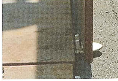
2.2枚目の敷鉄板を敷設してください。
