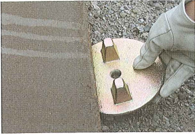
1.リンクプレート下部を敷鉄板に挿入します。
