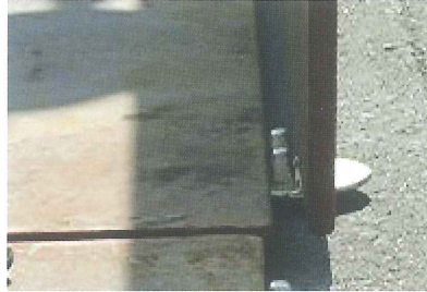
2.2枚目の敷鉄板を敷設してください。
